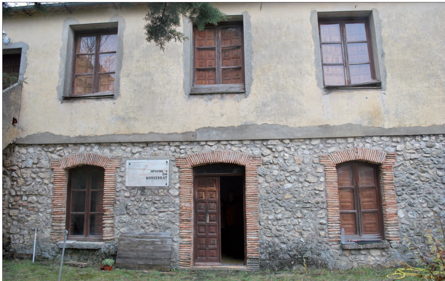
Patio del colegio en la actualidad, con la placa en el muro.
