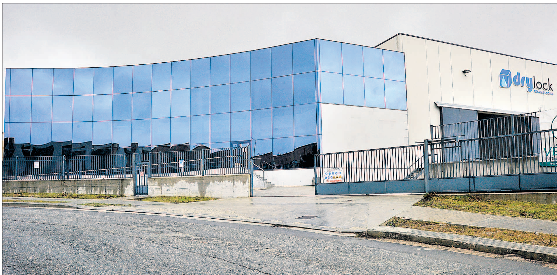
Las instalaciones de Drylock en Segovia ocupan una parcela de 25.000 metros cuadrados, en cuya adecuación se han invertido cerca de 700.000 euros./
