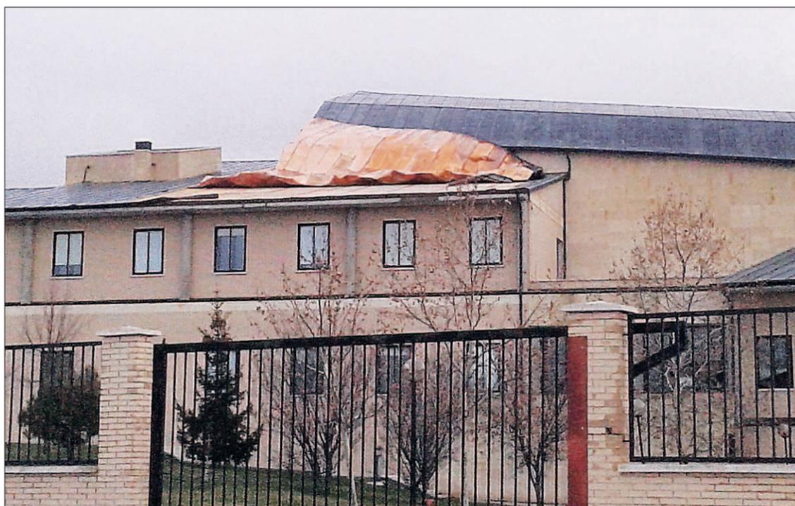
El aire volteó un gran trozo del tejado sobre la propia cubierta del edificio. / M.GALINDO.
