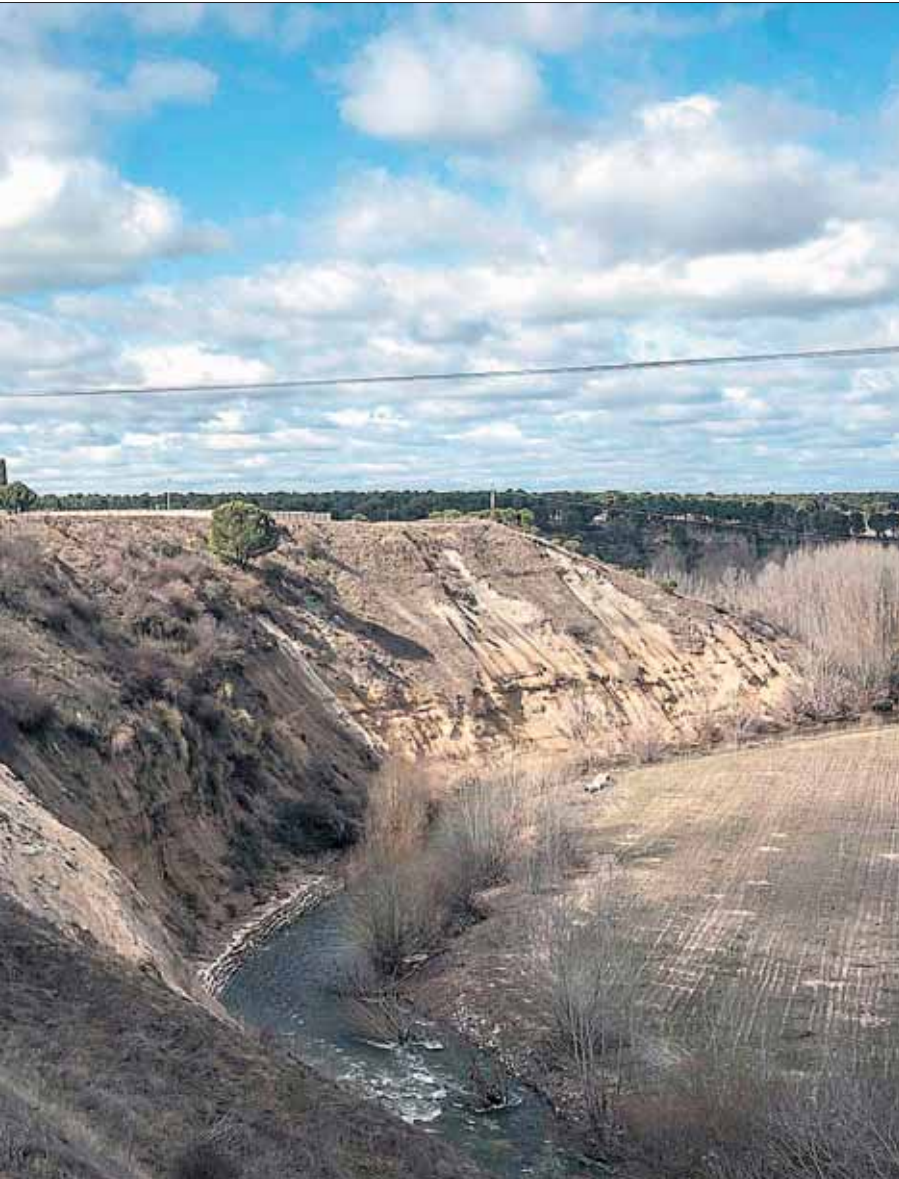
metros del cortado donde se producen los desprendimientos; a la derecha, el Eresma. / KAMARERO
