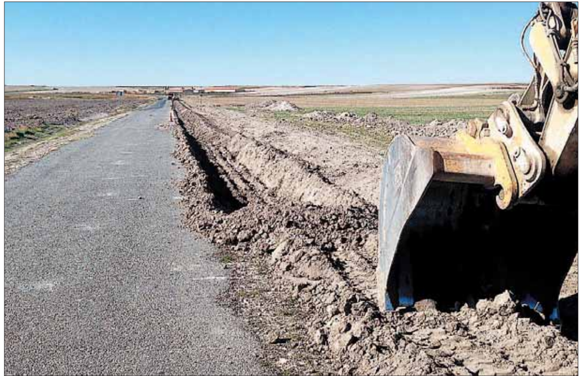
La actuación ha permitido ensanchar la carretera, dando más seguridad a los usuarios de la vía. / EL ADELANTADO
