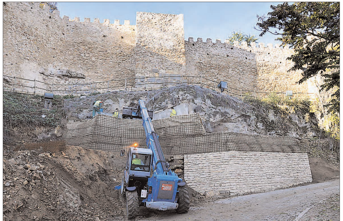
Trabajos en una de las últimas zonas de actuación en la Muralla, el tramo más próximo a la puerta de San Cebrián.
