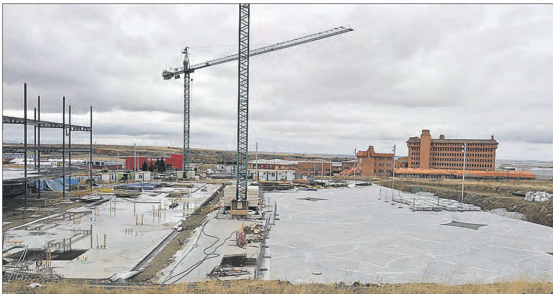
Imagen de las obras de construcción del edificio de emprendedores del CAT, que se paralizaron en noviembre.
