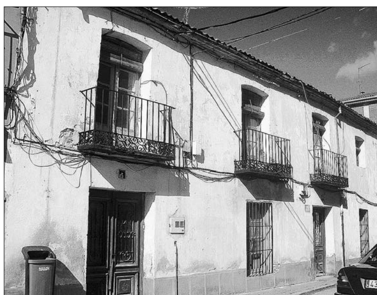
Edificio que será demolido en la Plaza Mayor. /LUCIO MARTÍN
