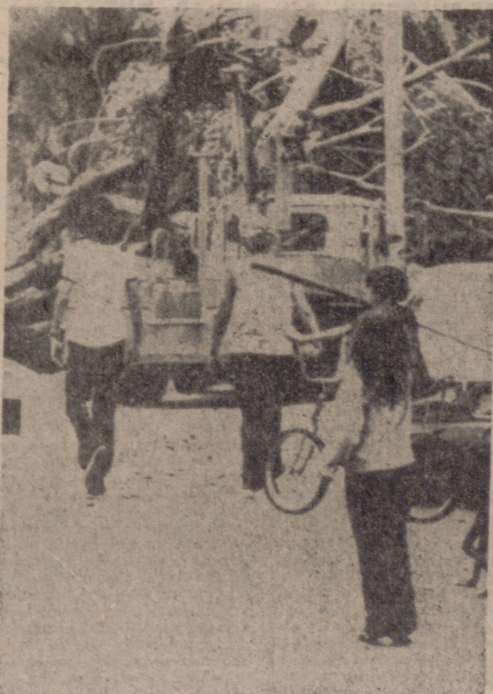
CORAL CABLES.—Algunos residentes en esta zona residencial de Florida contemplan cómo los equipos de la empresa eléctrica «Florida Power & Light Company» reparan los daños causados por un tornado, que derribó árboles y postes. El fenómeno y un accidente ocurrido a una grúa ocasionaron el mayor apagón registrado en el Estado. (Telefoto Cifra Gráfica-Upi)
