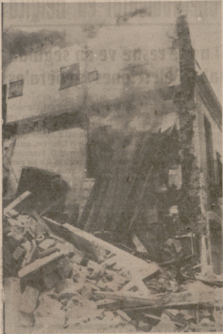
MATARO (Barcelona). —A un muerto y dos heridos se elevó el número de víctimas registradas en el derrumbamiento de los inmuebles números 9 y 11 de la calle de Barcelona, en esta ciudad. En la foto, un aspecto del derrumbamiento. (Telefoto Cifra Gráfica.)
