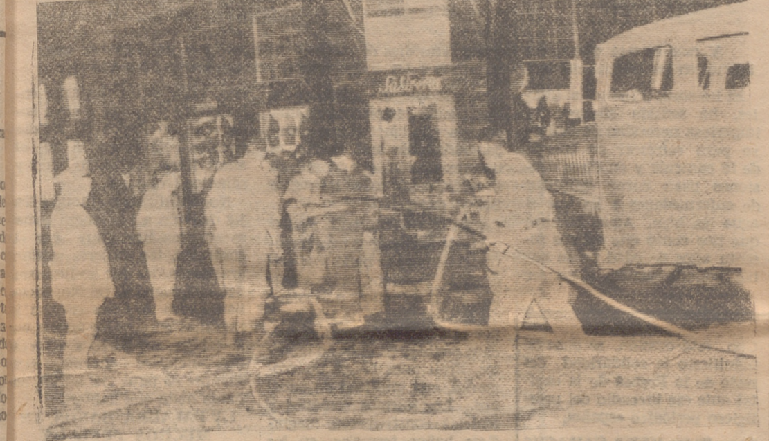
Mangueras de desagüe de la inundación producida en la Plaza de Abastos. — (Foto "Albe").
