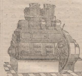
Su puesta en marcha es sencillísima completamente en frío, sin necesidad de motor auxiliar alguno de ignición, por manivela y sin estuerzo en potencias hasta 28 HP. y por aire comprimido en las mayores.
