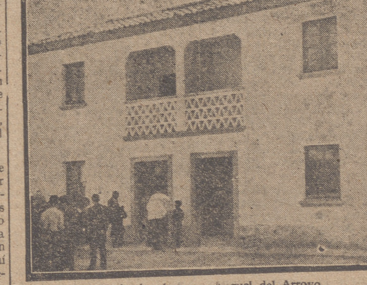
Viviendas de San Miguel del Arroyo
