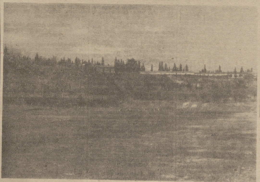
La parte de la pradera, en la que sólo queda este trozo llano y sin llenar de escombros.
