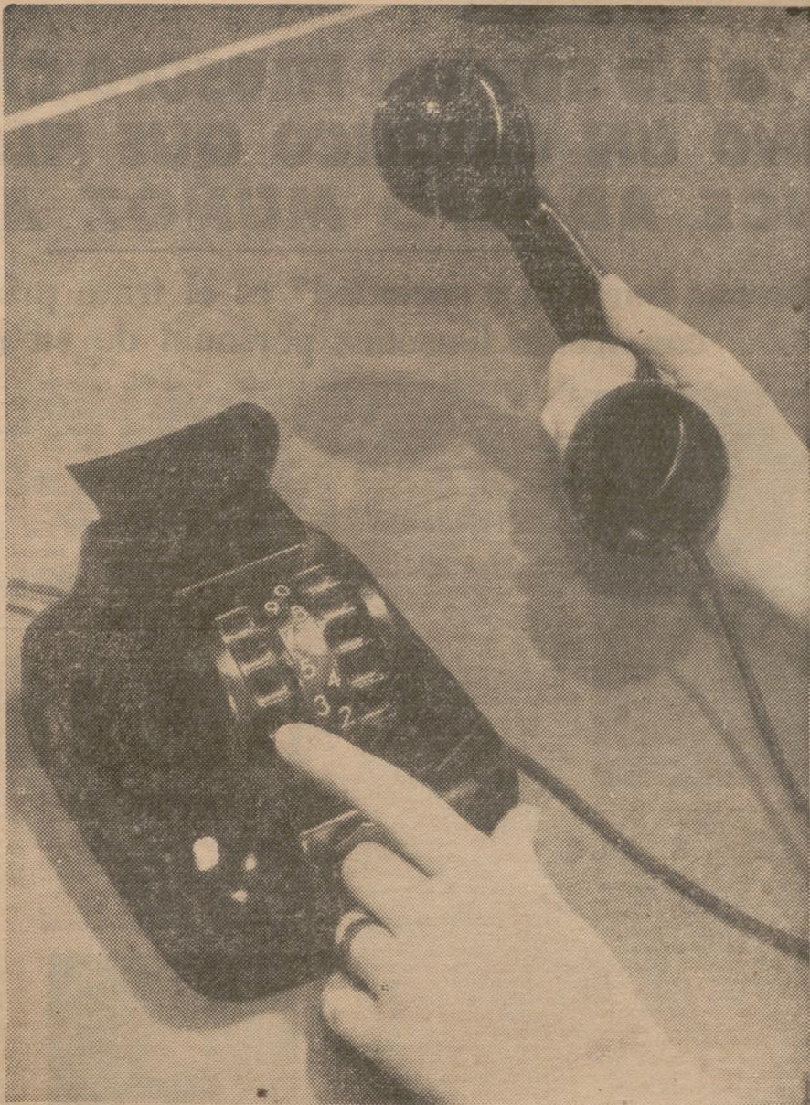
Una fábrica alemana ha lanzado este receptor telefónico, en el que el disco es sustituido por un doble tambor giratorio. El aparato lleva además un modulador de sonido.
