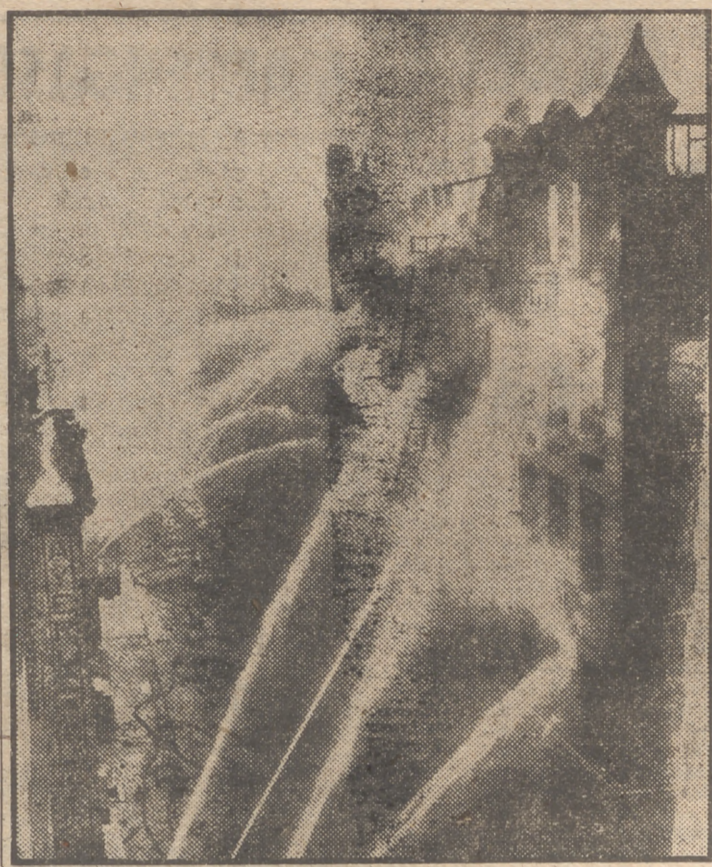
El incendio de este gran almacén de Filadelfia ocasionó pérdidas por valor de 81 millones de dólares y en su extinción sufrieron heridas tres bomberos de los trescientos que trabajaban. He aquí el emocionante momento en que una de las paredes del edificio se viene al suelo. (Foto A. P.)
