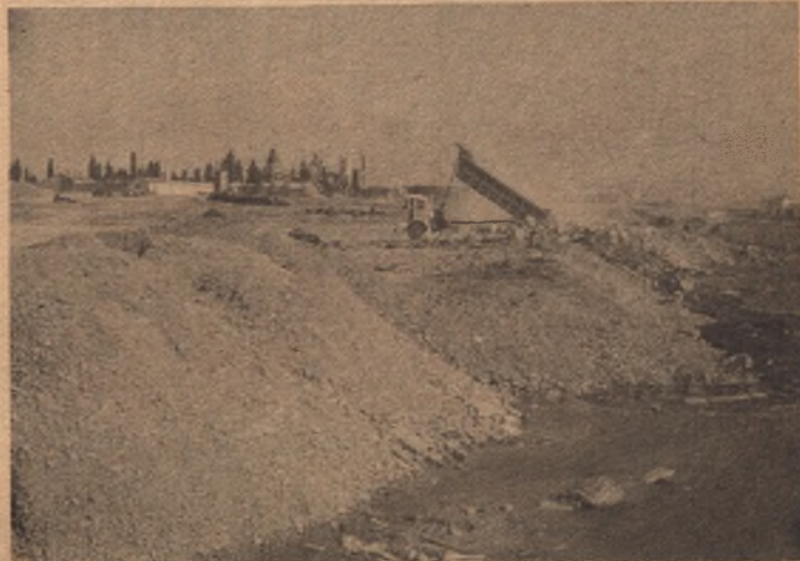
La foto muestra los costosos trabajos de nivelación que ha sido preciso realizar para adaptar los terrenos adquiridos por el Club, para el nuevo campo
