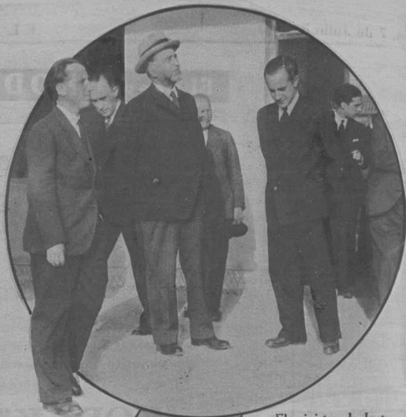
El ministro de Instrucción, visitando las obras del nuevo Instituto de Torrelavega (Fot. Samot)
