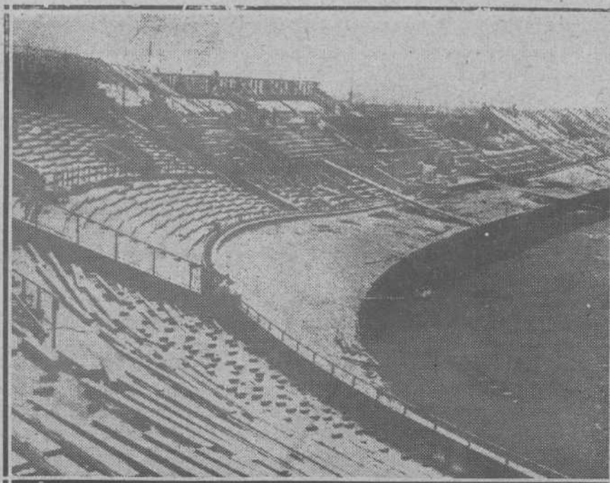
He aquí el estado de las obras del inmenso estadio que se está construyendo en Amsterdam para la próxima Olimpiada.
