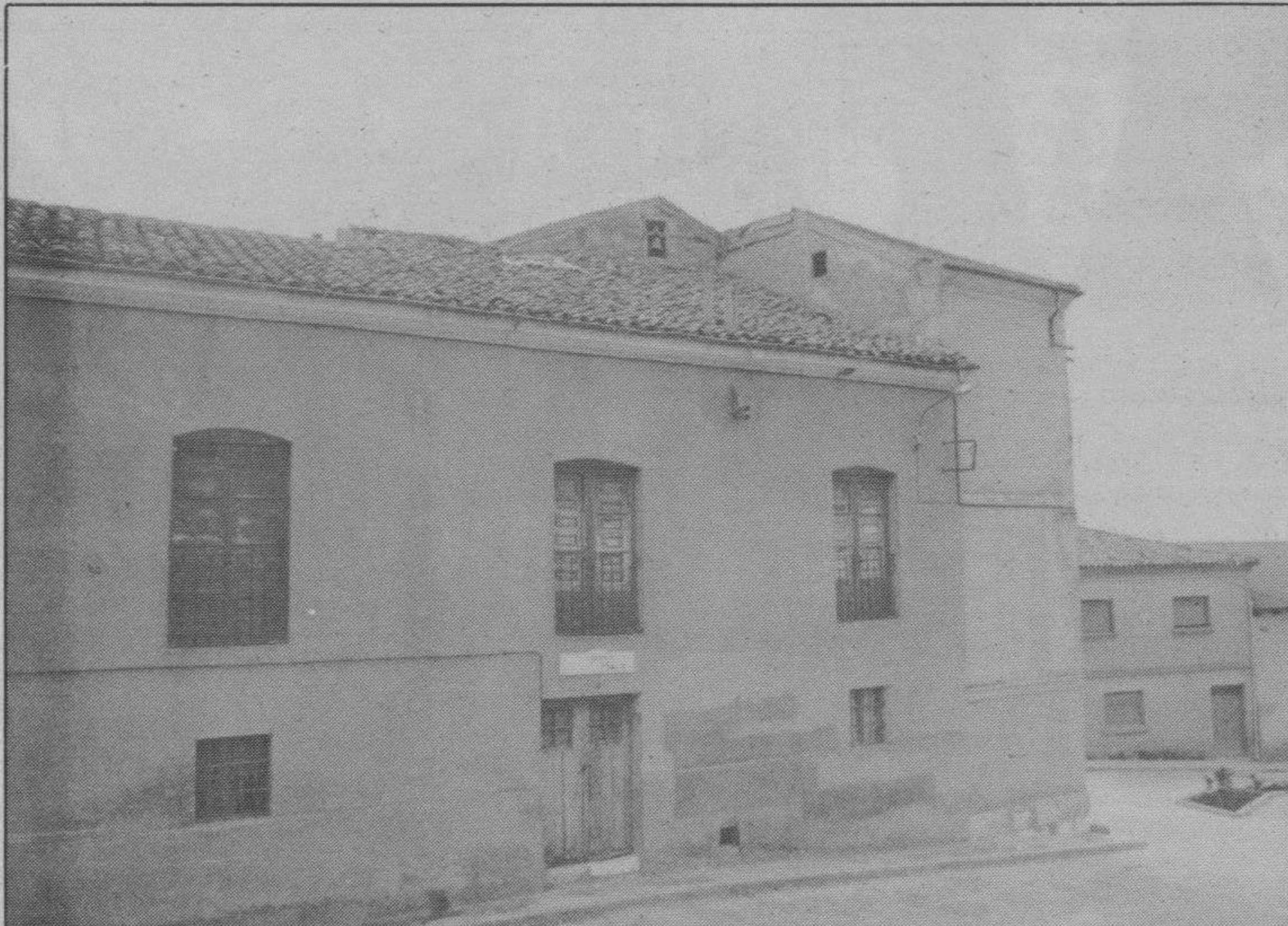
Las obras de dos mini-residencias están prácticamente terminadas. (Foto: Lara).
