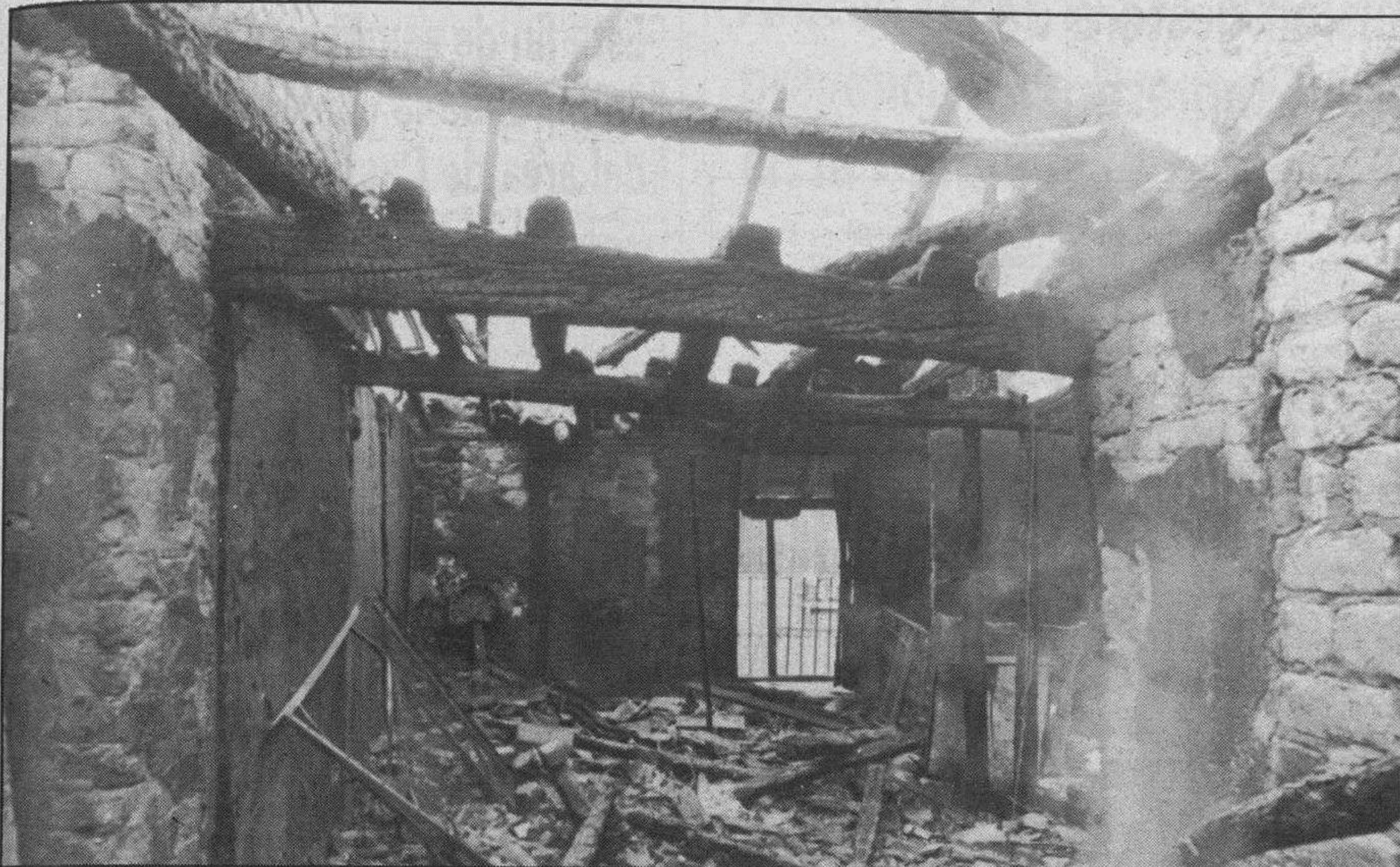
Todos los indicios apuntan a que el incendio comenzó en una chimenea. Foto Lara.
