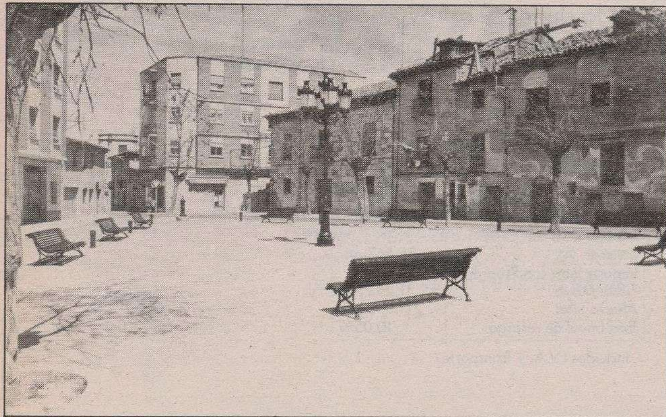
Obras de urbanización en el casco antiguo.— El casco antiguo de Aranda pasa por ser una de las zonas más abandonadas y peor conservadas de la ciudad. Sin embargo, y tras las obras de urbanización acometidas en los últimos tiempos, el núcleo primitivo de Aranda está sufriendo una notable y positiva transformación. La plaza de las Francesillas y
