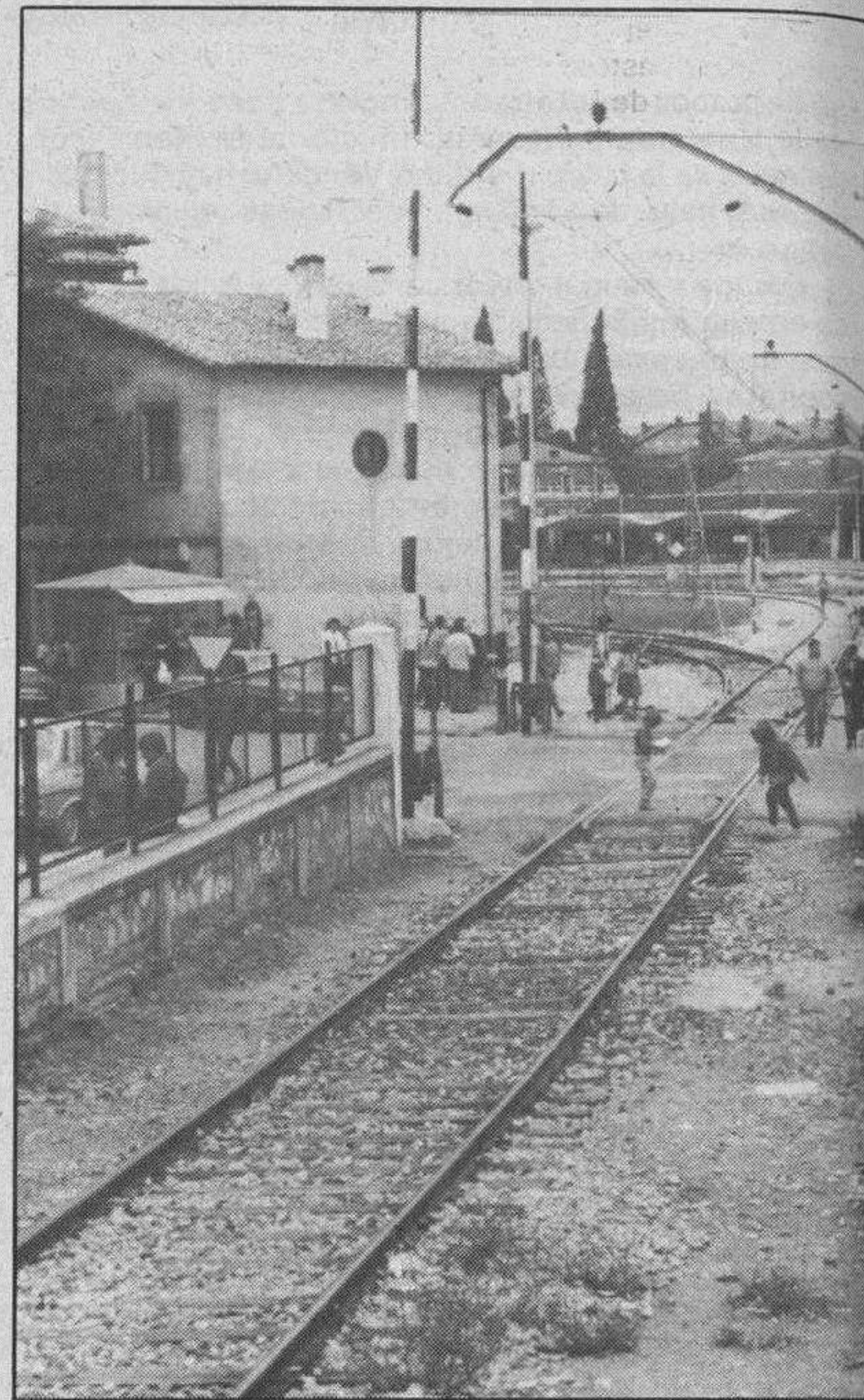
Paso a nivel de Santa Dorotea
