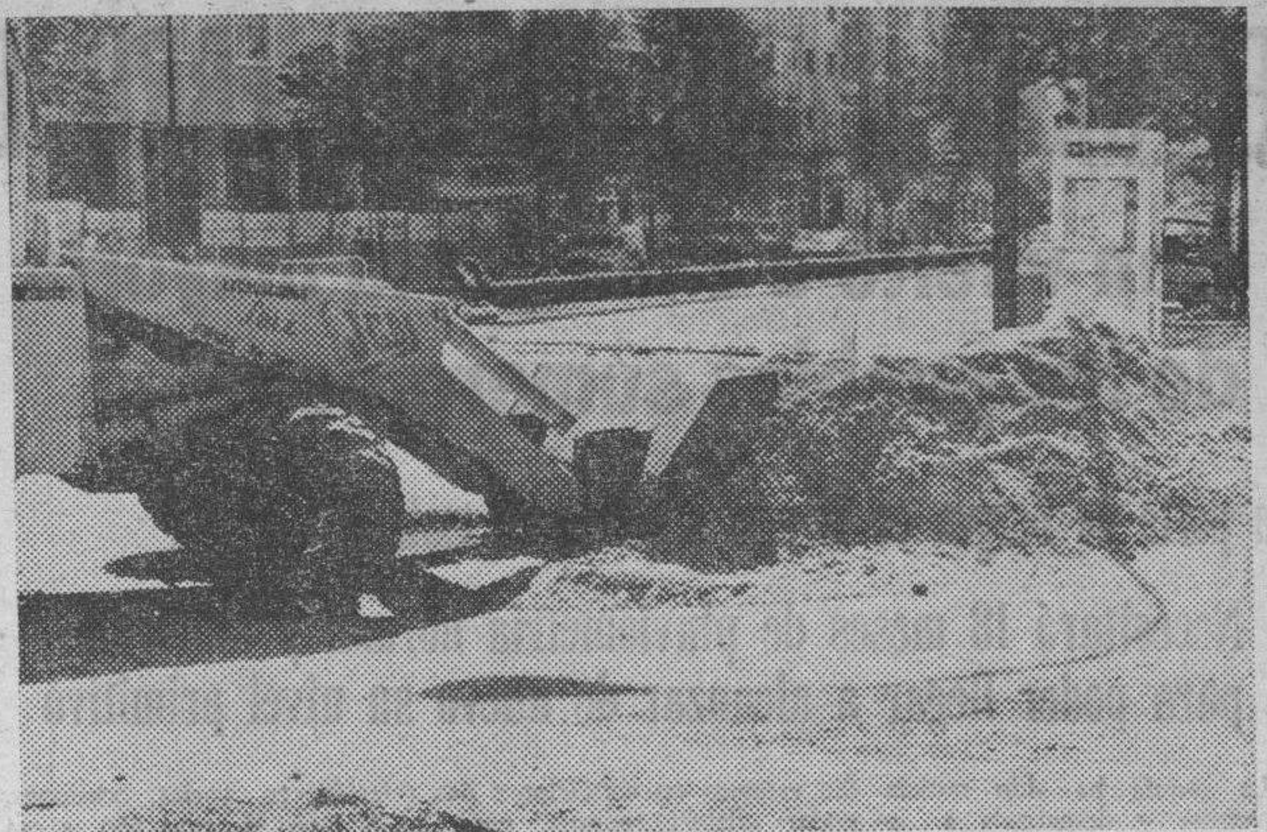
Estas son las obras que se llevan a cabo estos días en la avenida del Cid, con motivo del acondicionamiento y mejora de la red distribuidora de agua. — (Foto FEDE)
