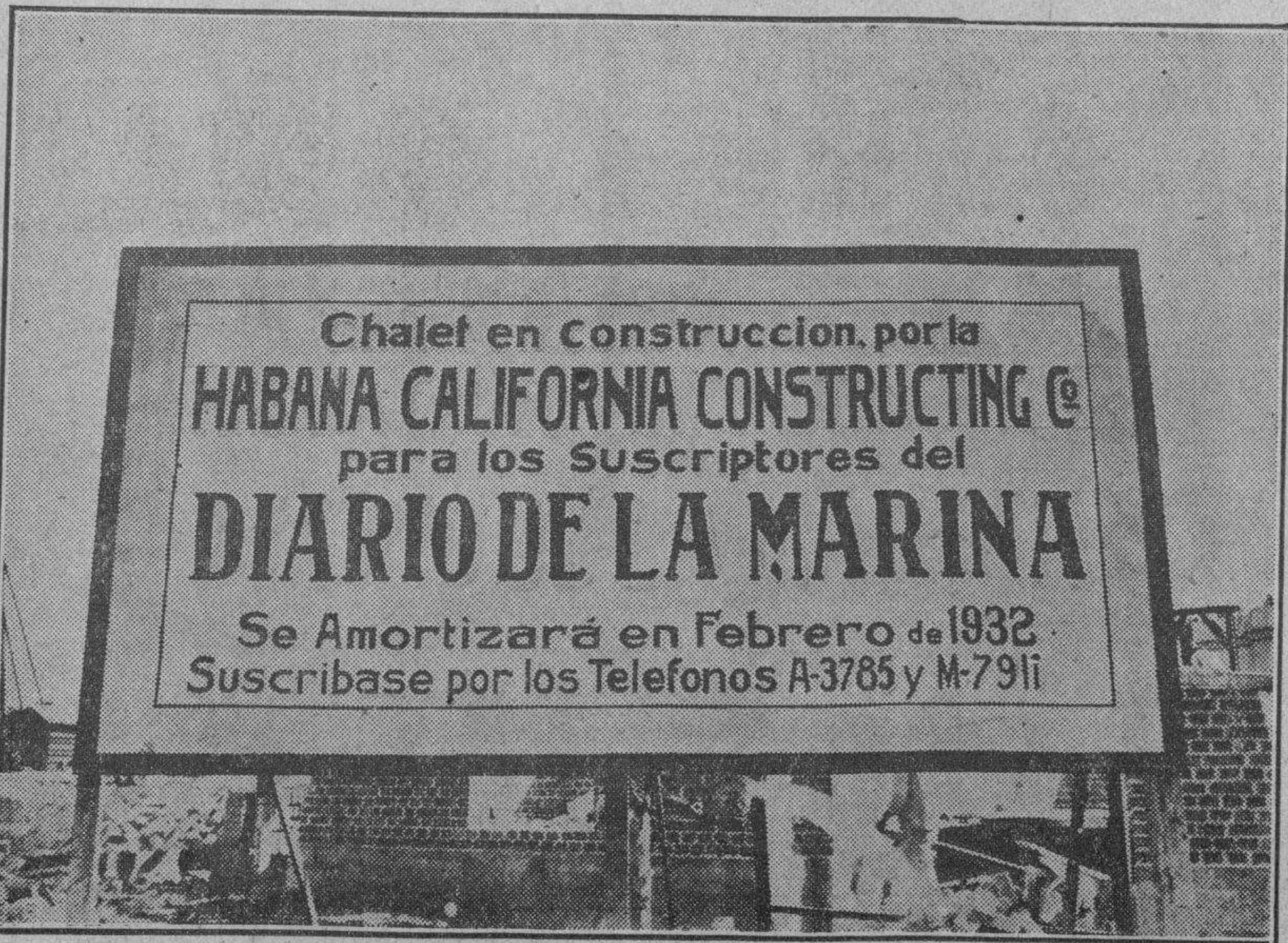
Cartel colocado en el frente del Chalet en construcción para la «Unión Mutualista de Suscriptores del DIARIO DE LA MARINA»
