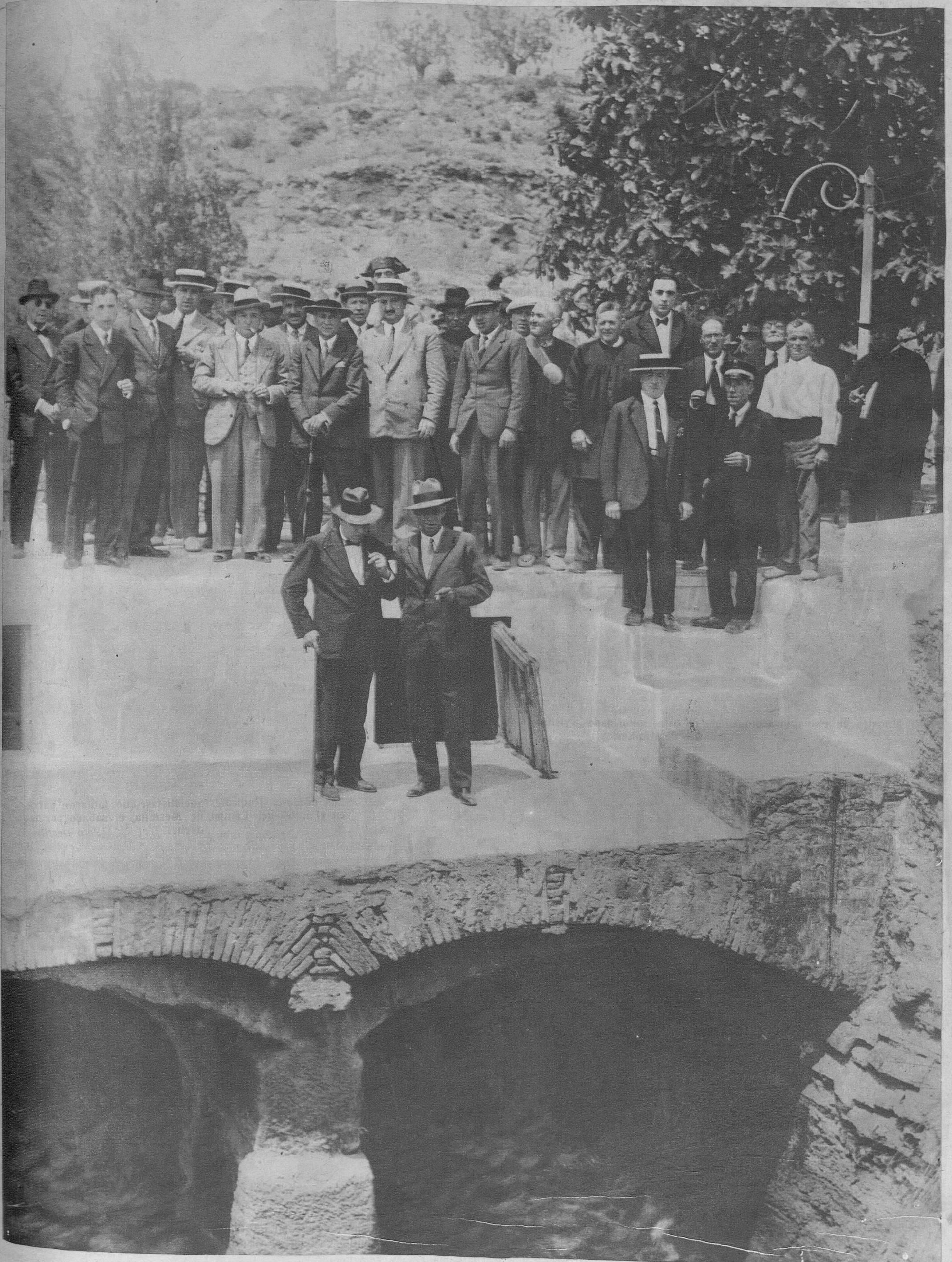
Visita del Ministro de Fomento a la Presa de Moncada.
