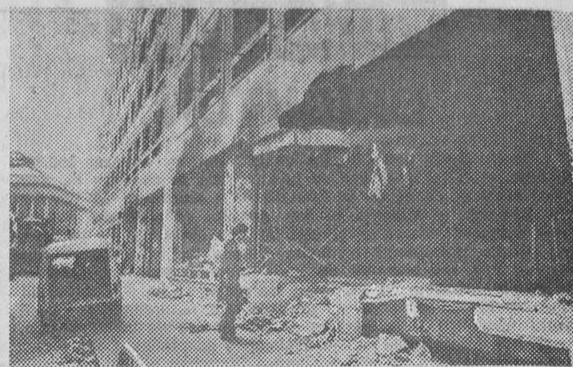
Las explosiones ocasionaron importantes daños en los locales del «Club Mediterraneo». (Foto UPI-EFE.)
