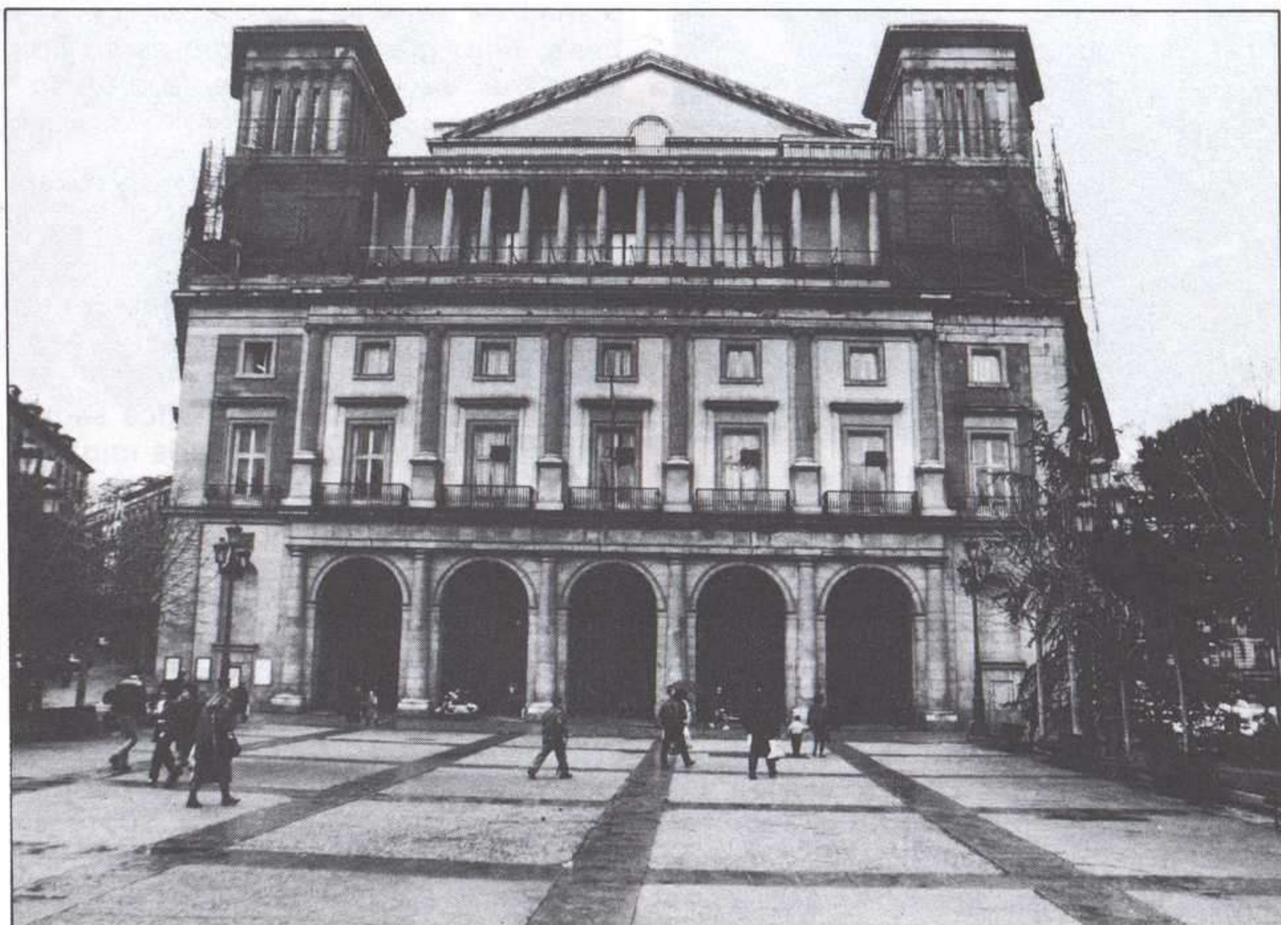
Fachada principal del Real Conservatorio de Música de Madrid.
