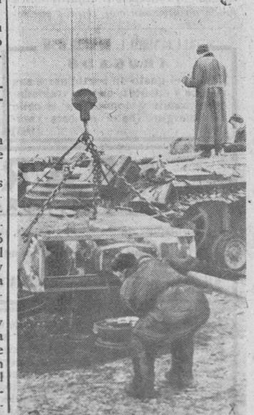
En un taller de campo, se realiza el montaje de un motor al tanque, que inmediatamente tomará parte en el combate
