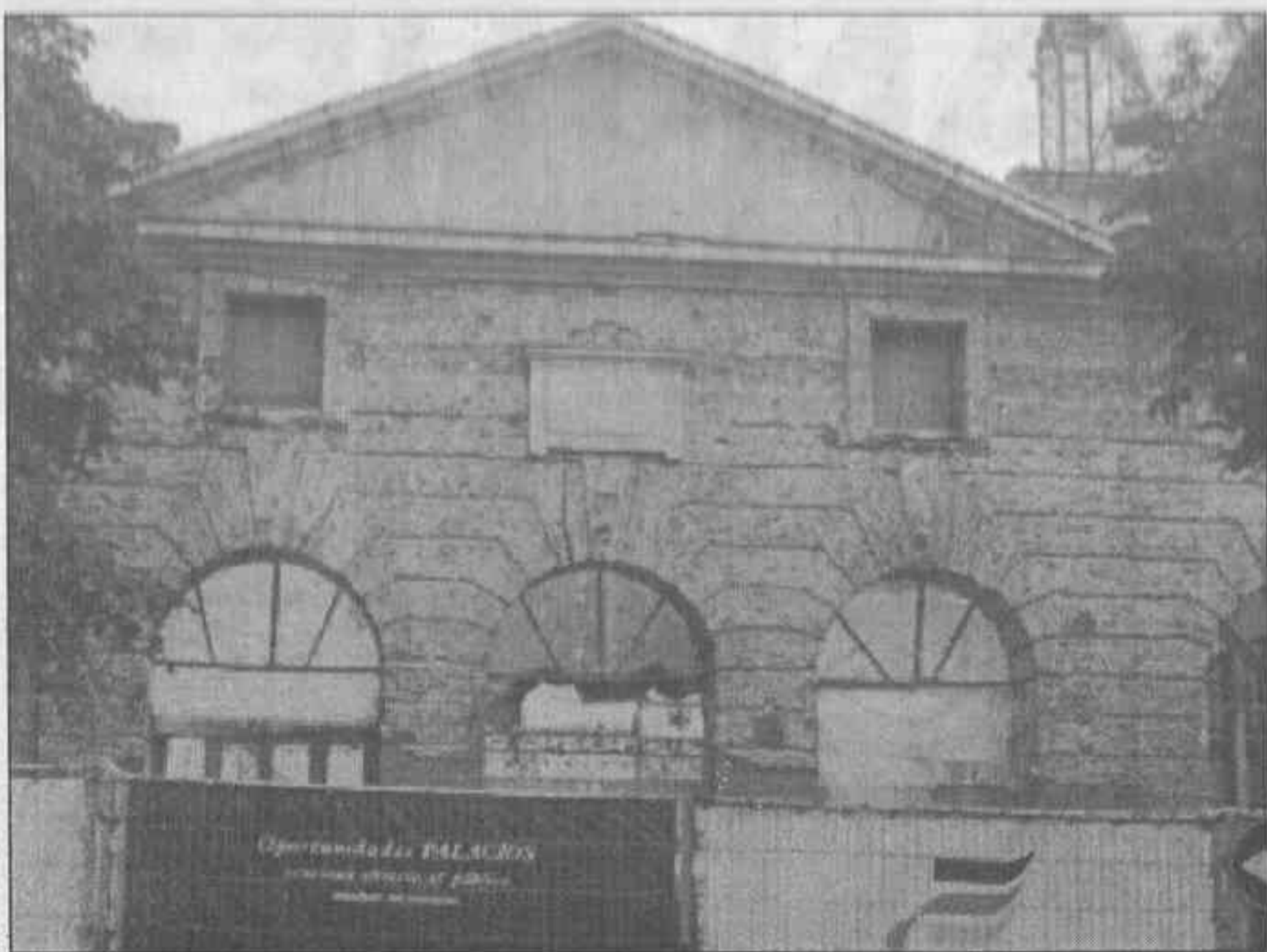
Durante el pasado verano hasta se retiraron las máquinas que iban a ser utilizadas en las obras del Coliseo Carlos III.
