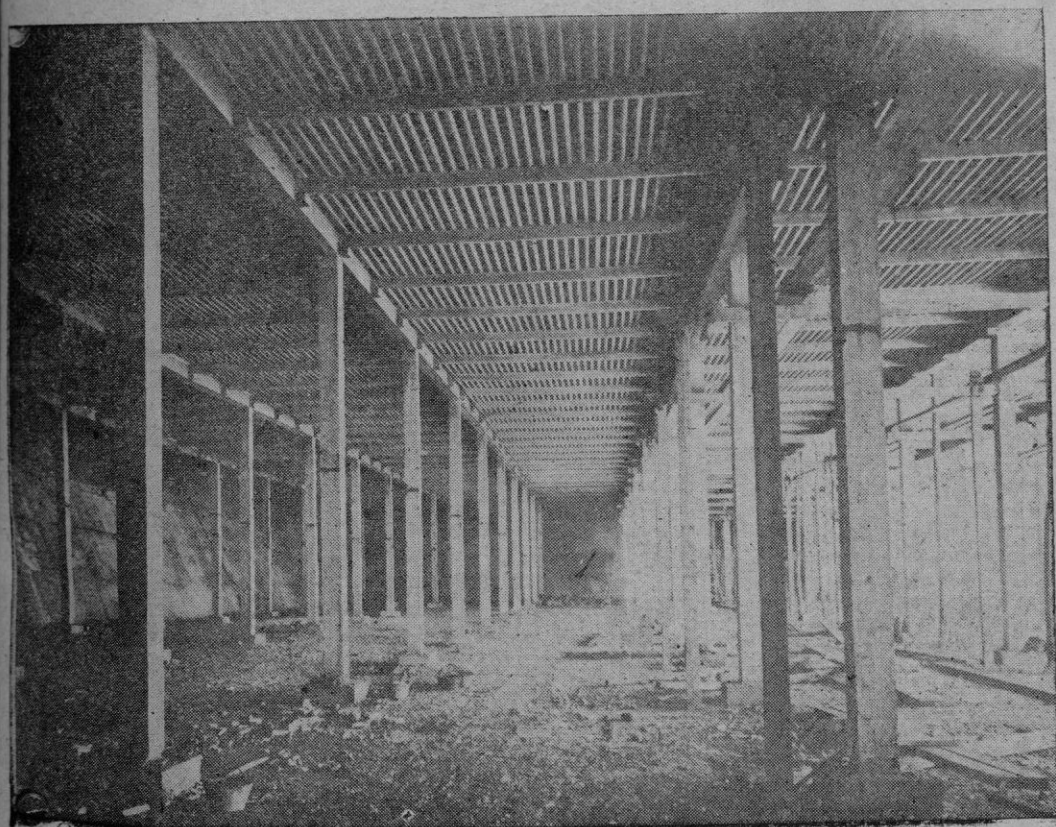
Interior de uno de los depósitos de Són Togores. La fotografía se tomó cuando se estaba construyendo. En cada uno de los dos depósitos caben 11 milímetros cúbicos de agua, cantidad que hoy, en régimen de servicio normal, no basta para un día.
