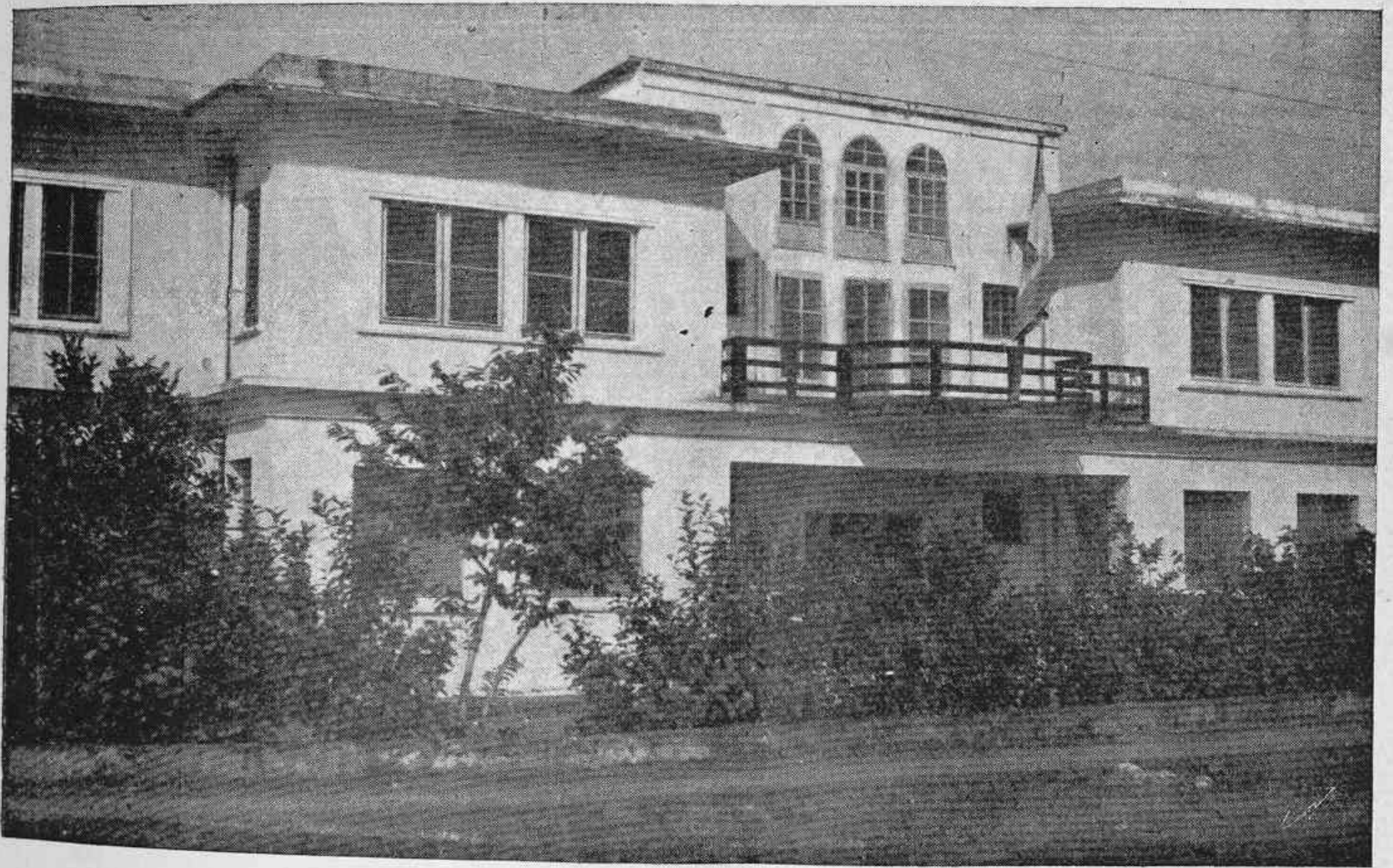
Sta. Isabel— Obras Públicas
