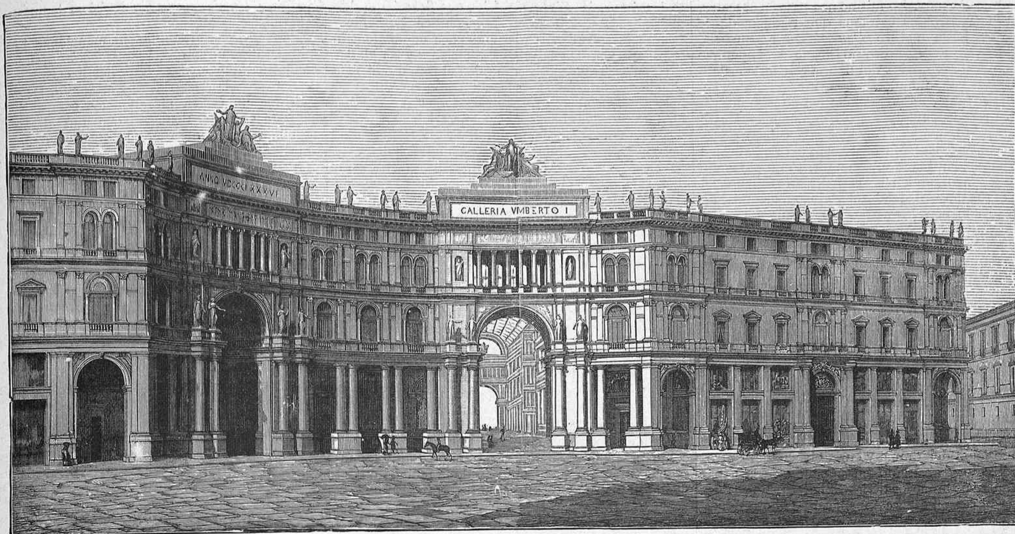
GALERÍA UMBERTO I, RECIENTEMENTE INAUGURADA EN NÁPOLES, obra del arquitecto Ernesto di Mauro
