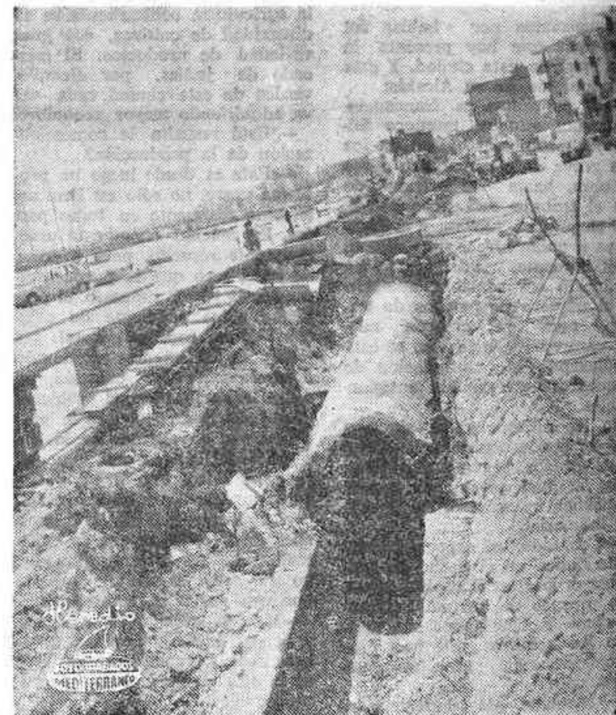
Importantes obras en el alcantarillado
