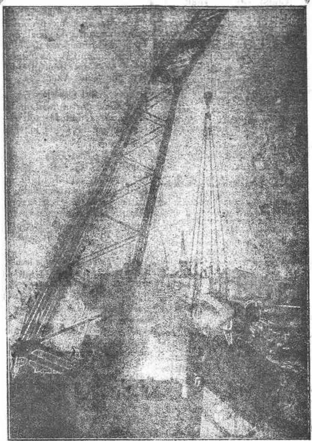
Kiel.—Un submarino alemán es lanzado al agua por una grúa flotante, después de haber sufrido la reparación de sus averías.
