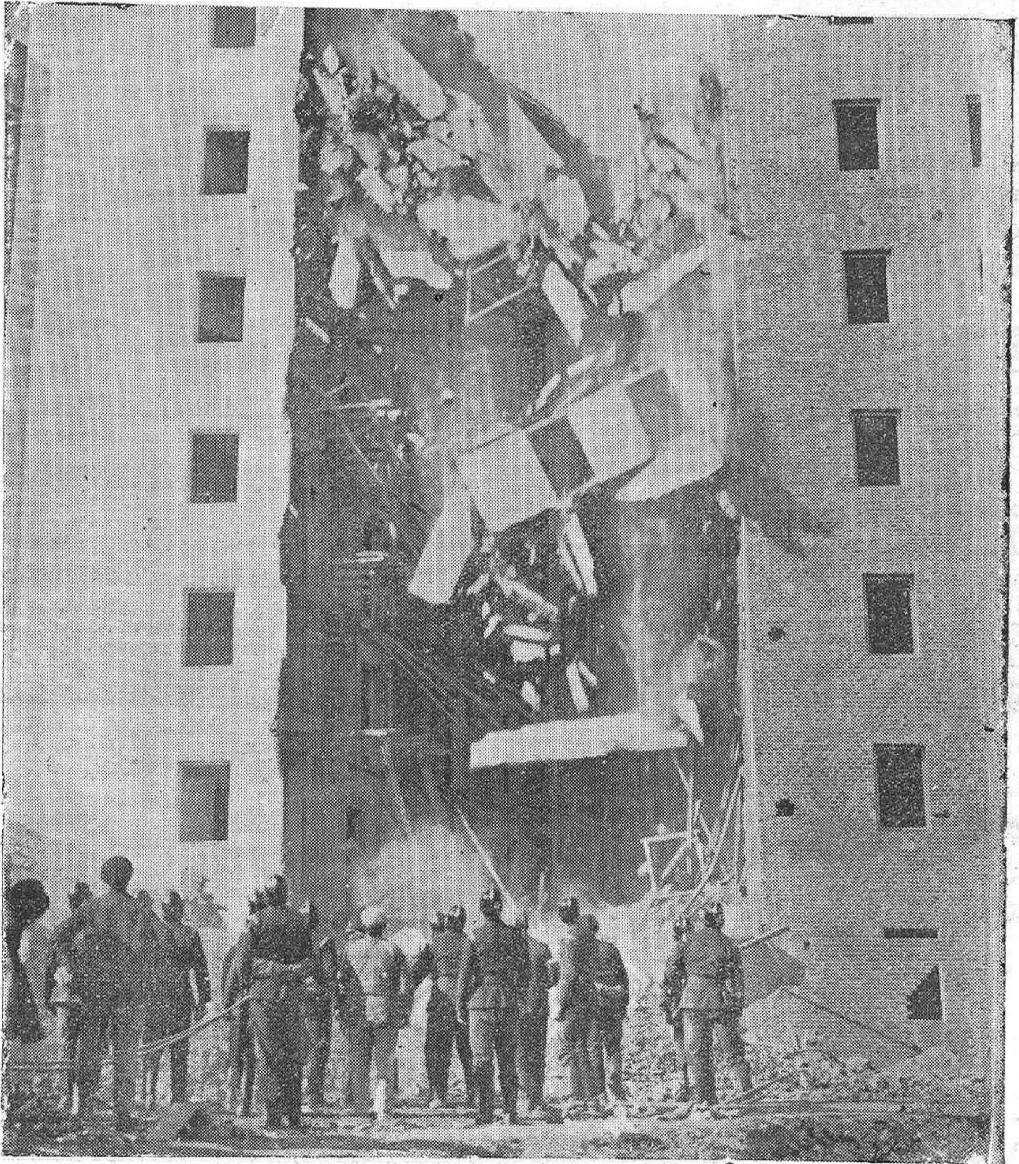
MADRID.—HUNDIMIENTO DE UNA CASA.—MOMENTO DE PRODUCIRSE EL DERRUMBAMIENTO DE LA CASA EN CONSTRUCCION DE LA CALLE DE ALONSO CANO Y QUE PRODUJO VARIOS MUERTOS Y HERIDOS.
