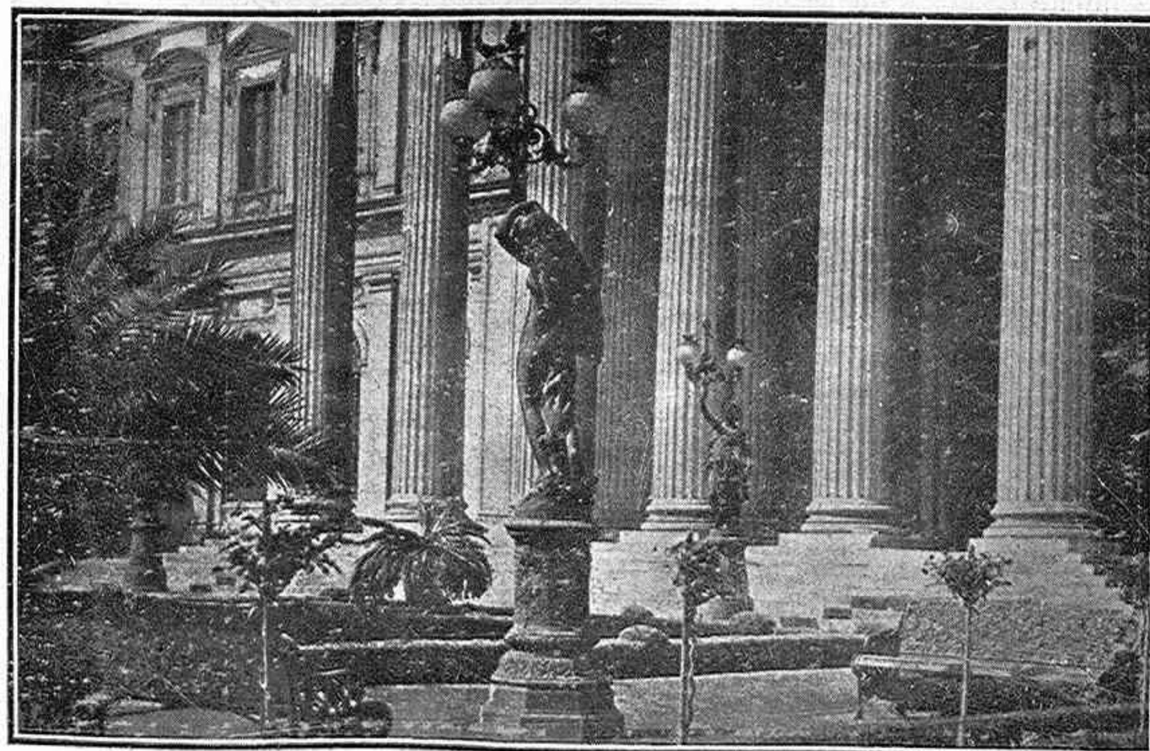
Detalle de la fachada principal del Congreso Nacional de Santiago de Chile
