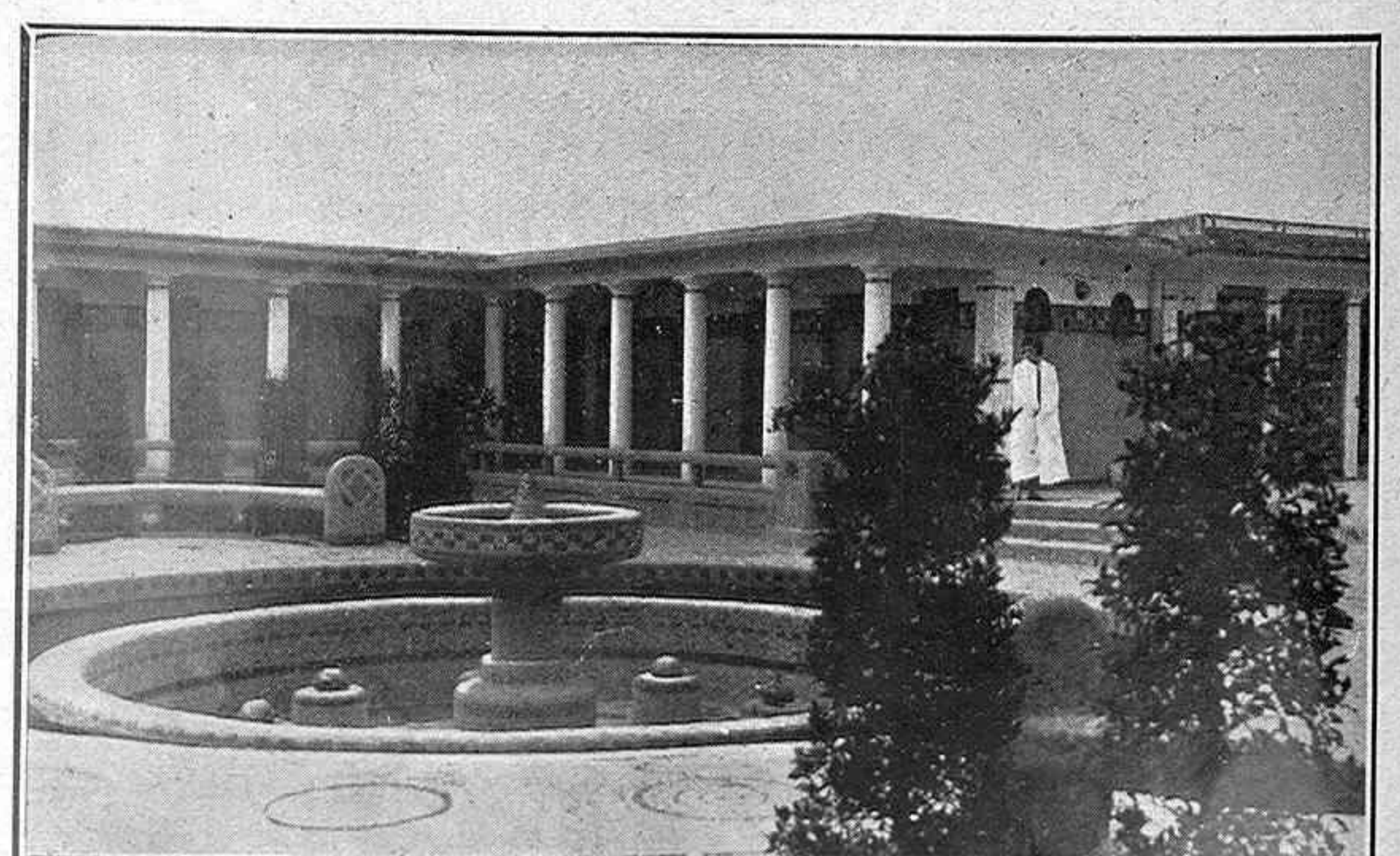
Patio y cabinas de los baños romanos
