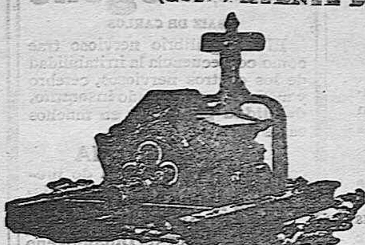
Nuevo aparato perfeccionado para extraer agua, aprovechando los areadores hasta la última gota del líquido, y con el más pequeño esfuerzo de las caballerías, por la disposición de la artesa y por la suavidad de los rozamientos monosistos sobre armadura de cilindros.
