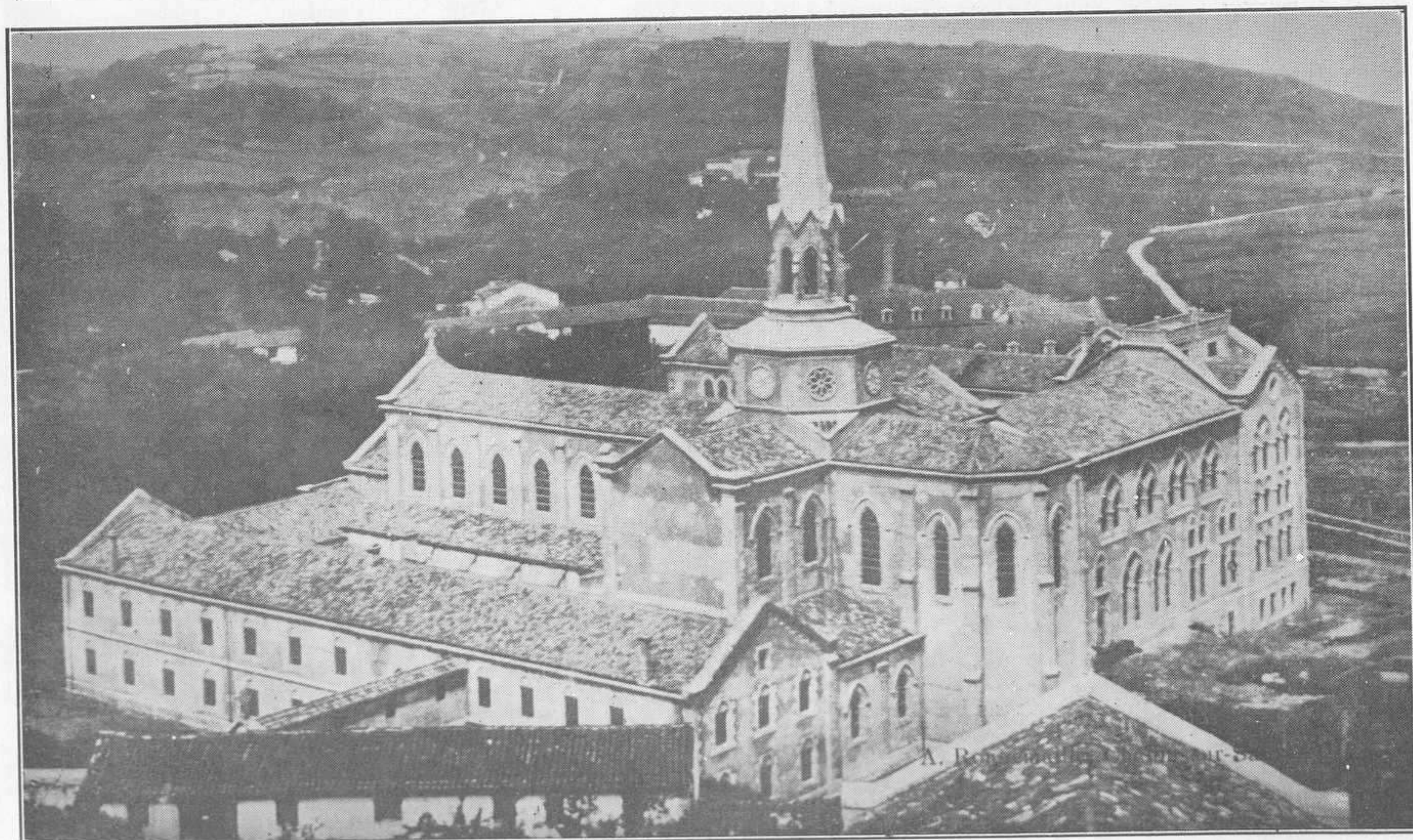
COBRECES.—Vista general del Monasterio Cisterciense de Viaceli.
