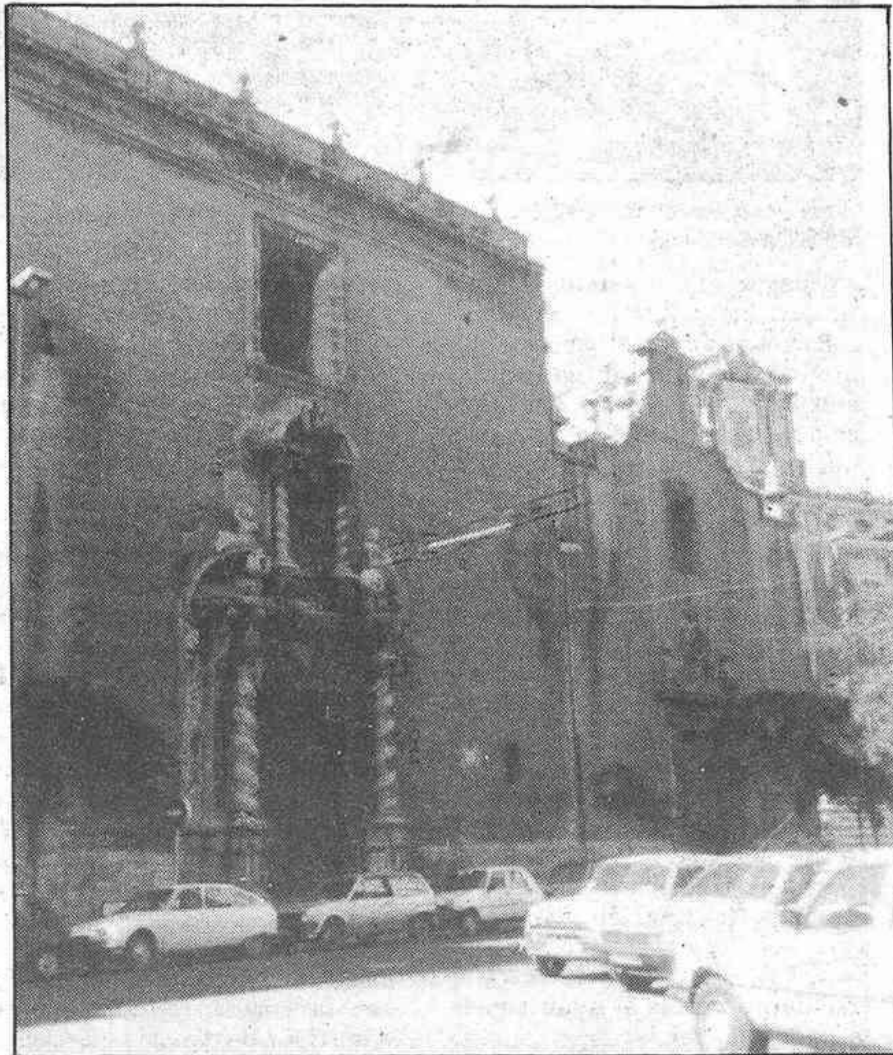
Fachada principal de la antigua Parroquia de San Andrés
