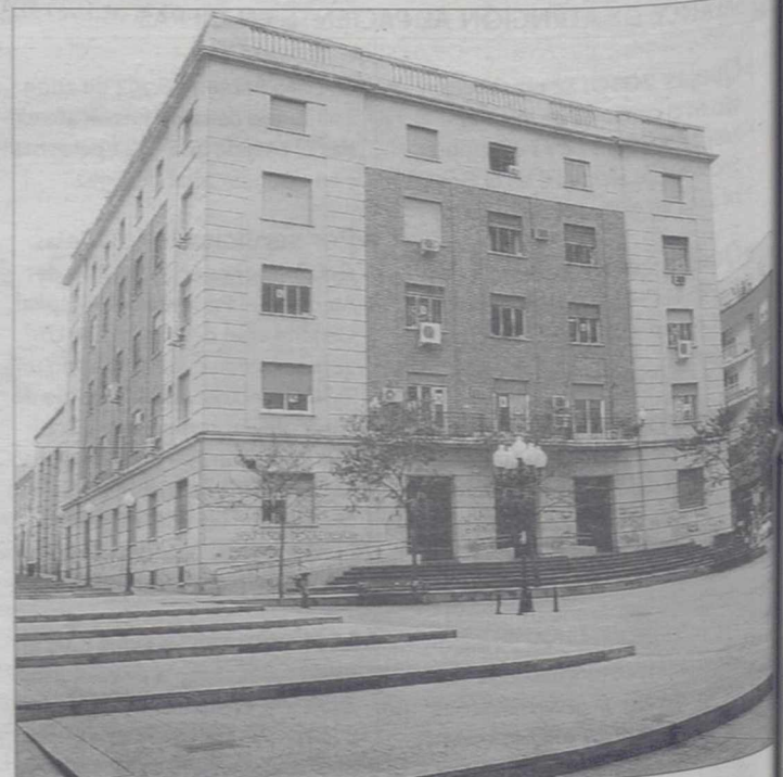
Edificio donde están las principales dependencias de UGT Albacete. / A.P.
