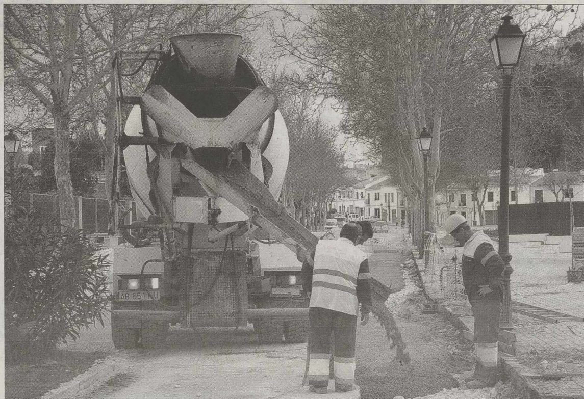
Obras de nuevas canalizaciones del agua. / LUIS BONETE
