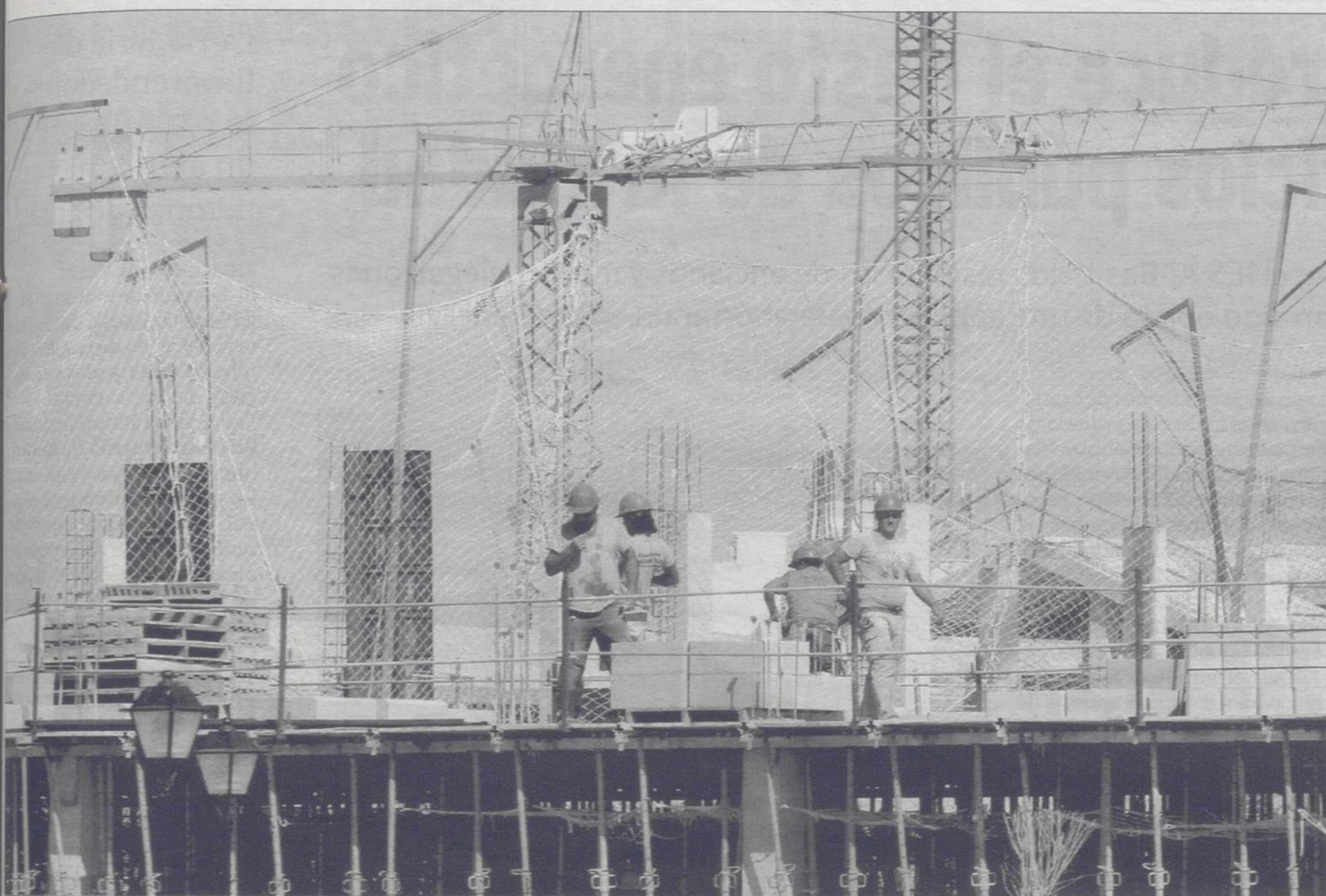
Imagen de archivo de obreros de la construcción trabajan en un nuevo edificio de viviendas de la ciudad. / ARTURO PÉREZ
