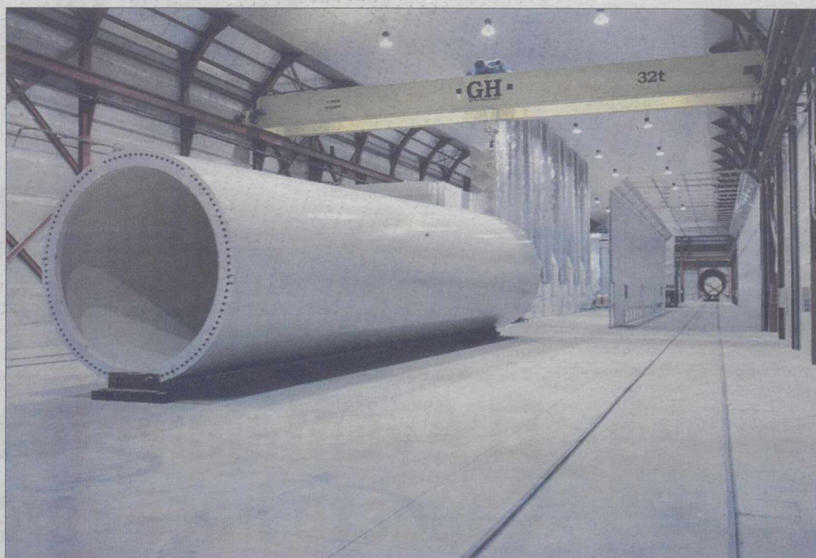
Instalaciones de una empresa eólica afincada en el actual polígono industrial. / R.SERRALLÉ
