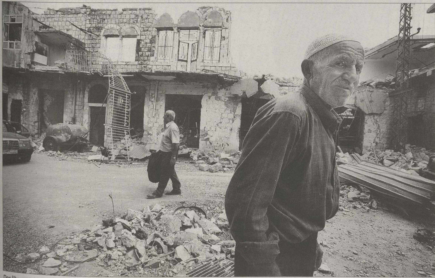
Dos libaneses inspeccionan los daños en el centro de Bent Jbail, una ciudad que ha quedado casi completamente destruida por el conflicto. / MIKE NELSON (EFE)
