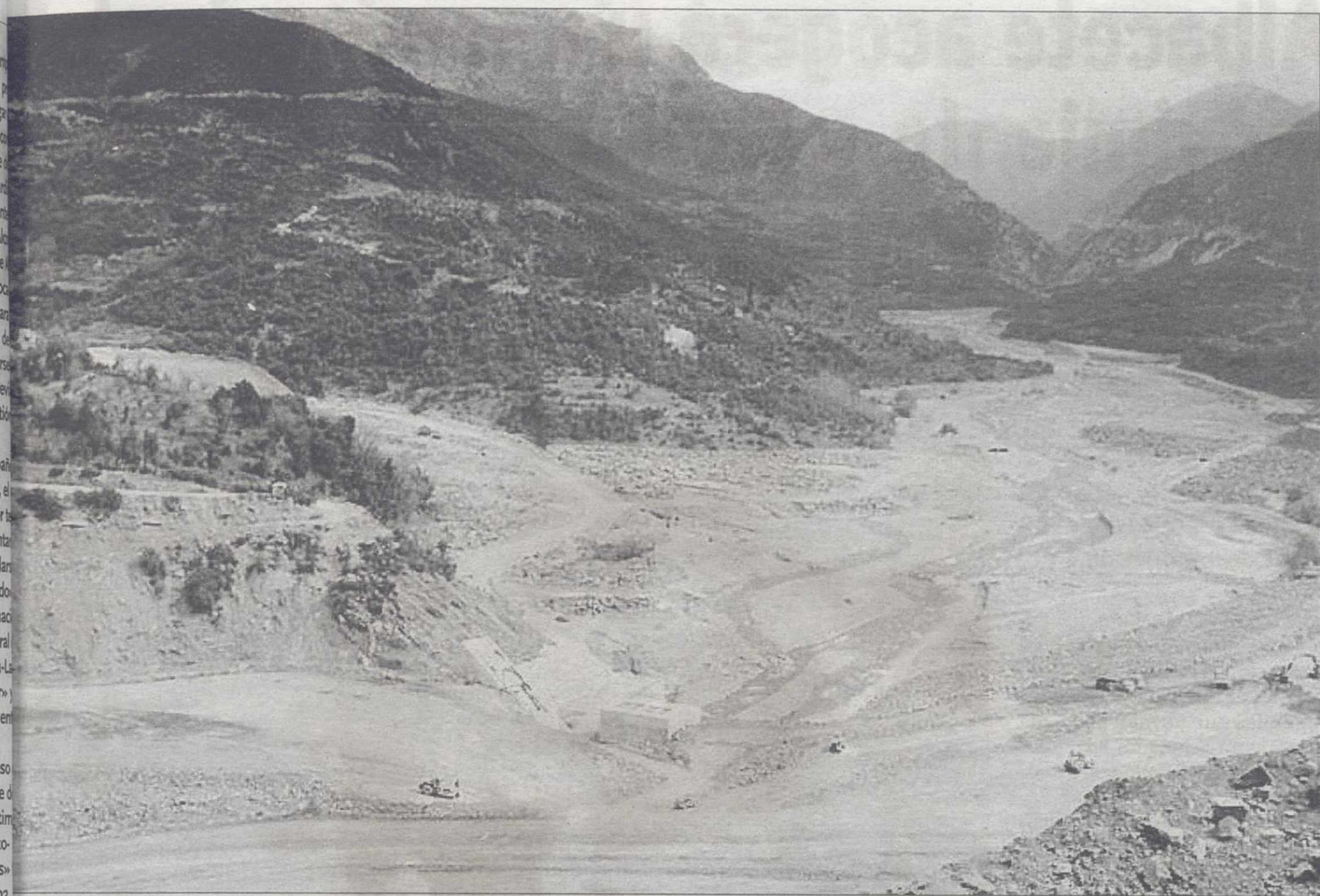
Trabajos de la construcción de una presa. / COMISION EUROPEA
