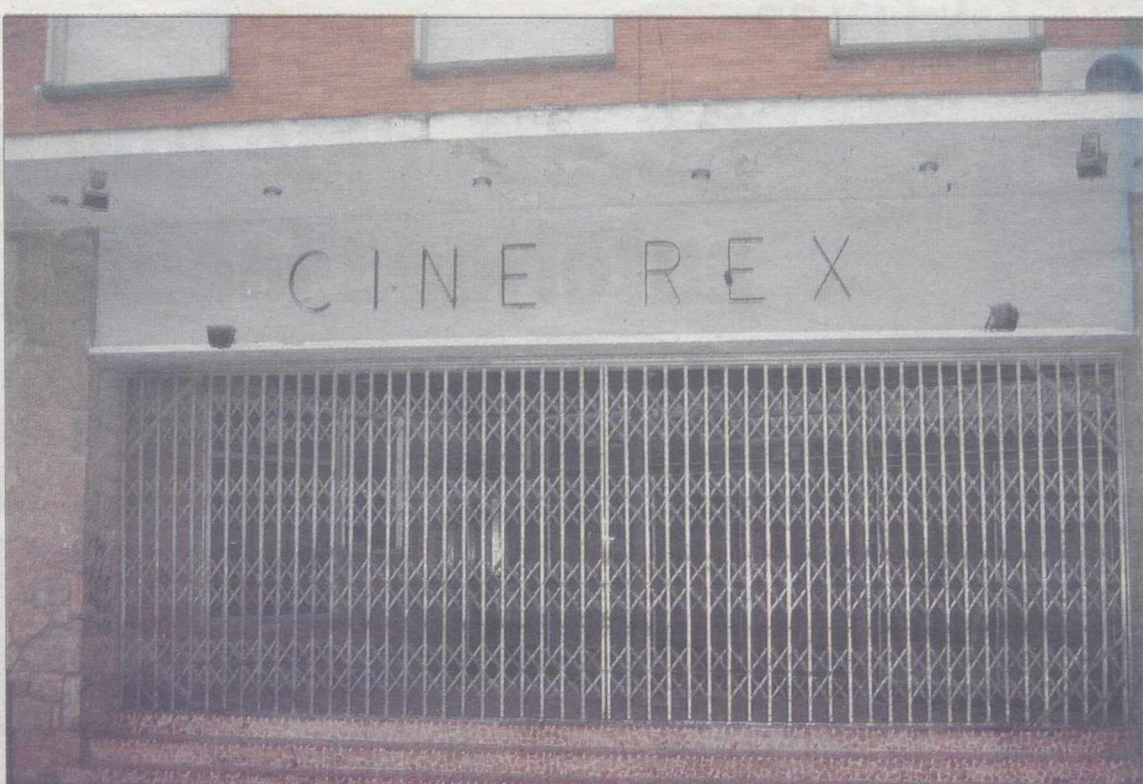
Fachada principal del cine Rex./M. PICÓ
