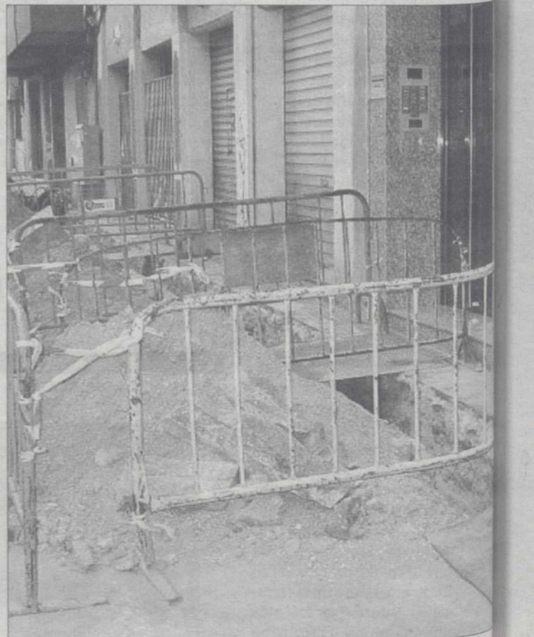
Obras de instalación de la conducción de gas natural. /LA TRIBUNA
