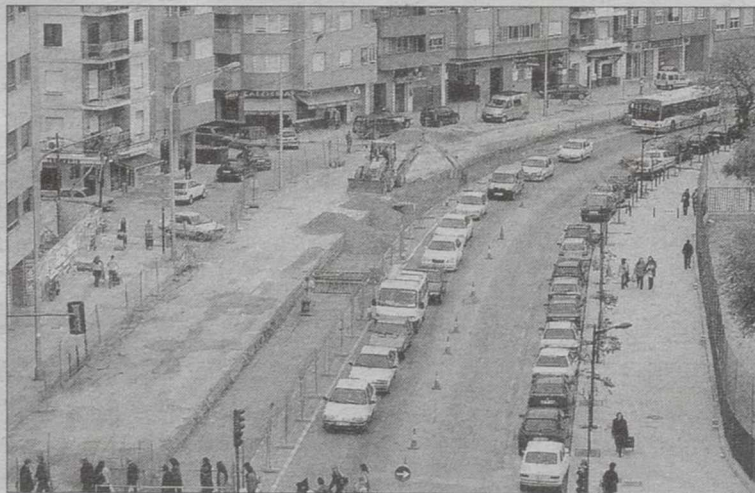
Estado de las obras de Circunvalación durante la visita del alcalde. /C. LOPEZ
