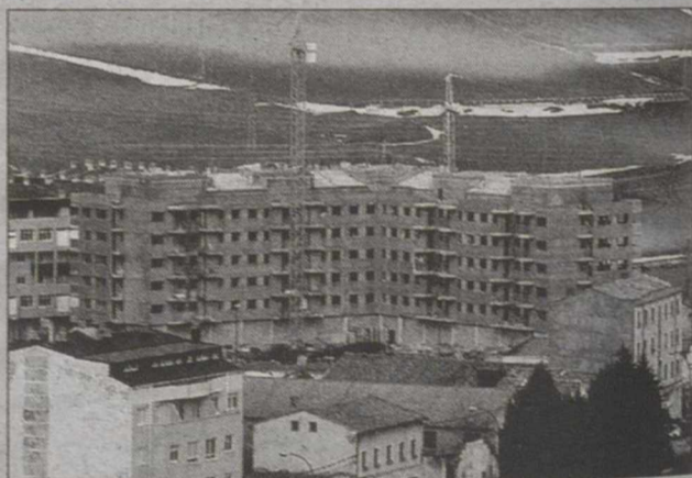
Varios bloques de viviendas, durante el proceso de construcción. J.L.L.A.
