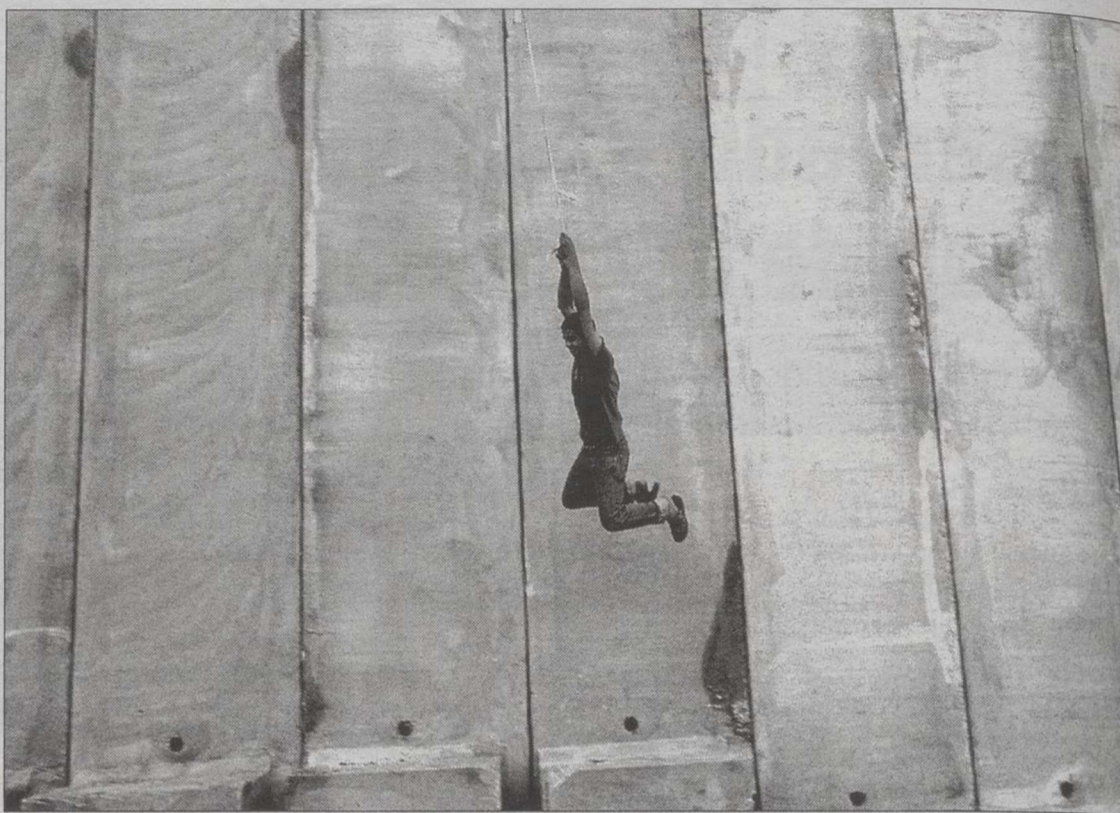
Un joven palestino pende de una grúa en la obra de la construcción de la pared de separación en Cisjordania. / P.W. (EFE)
