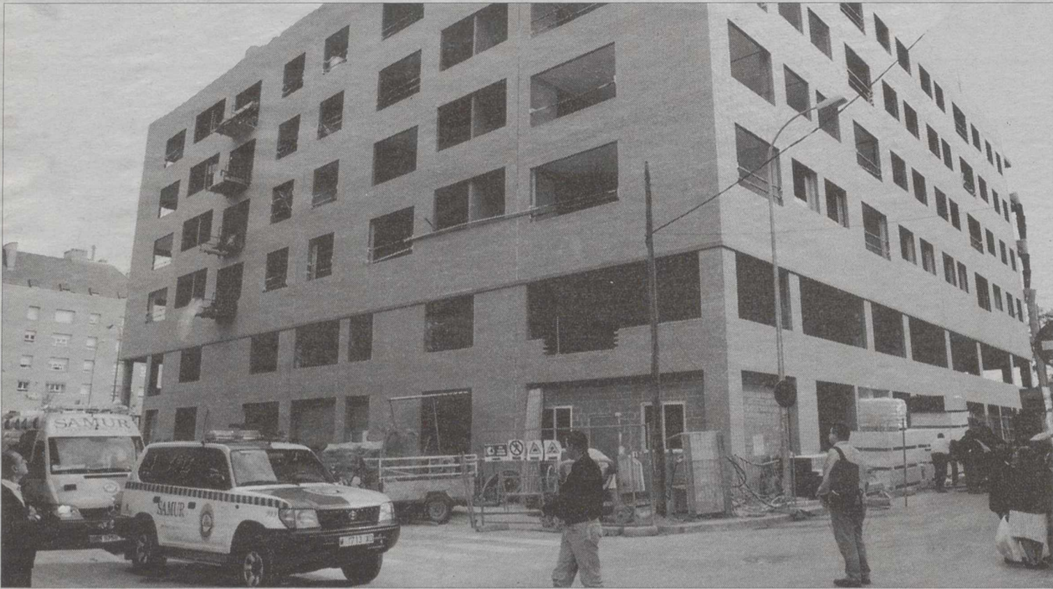
Un edificio en construcción.
