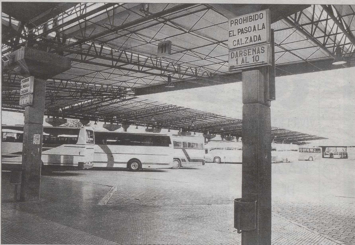
Los arreglos de las dársenas y los aseos exteriores completarán la remodelación de la Estación de Autobuses/ARTURO PEREZ
